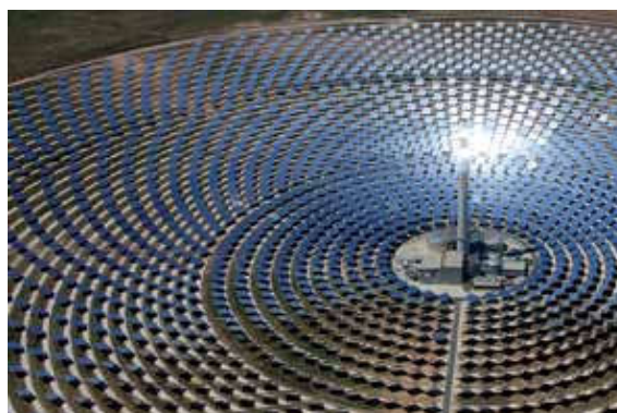
Met parabolische spiegels (concentrating solar power, zon-CSP) wordt hoge-temperatuur warmte opgewekt.
